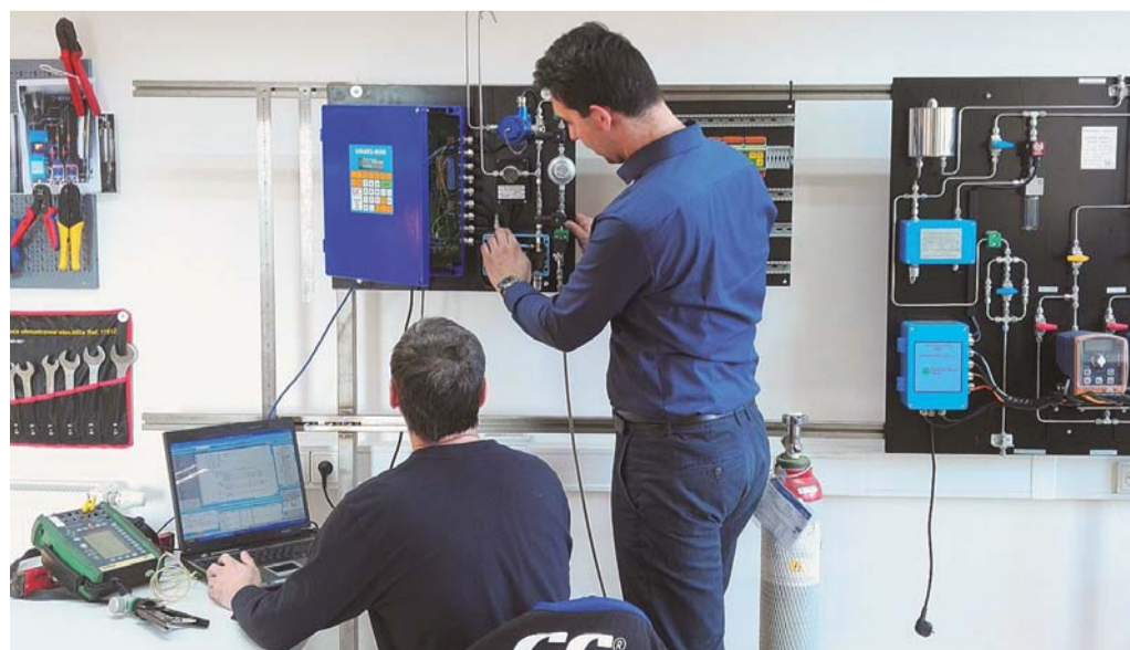
Z provozu – testování odorizačních jednotek
