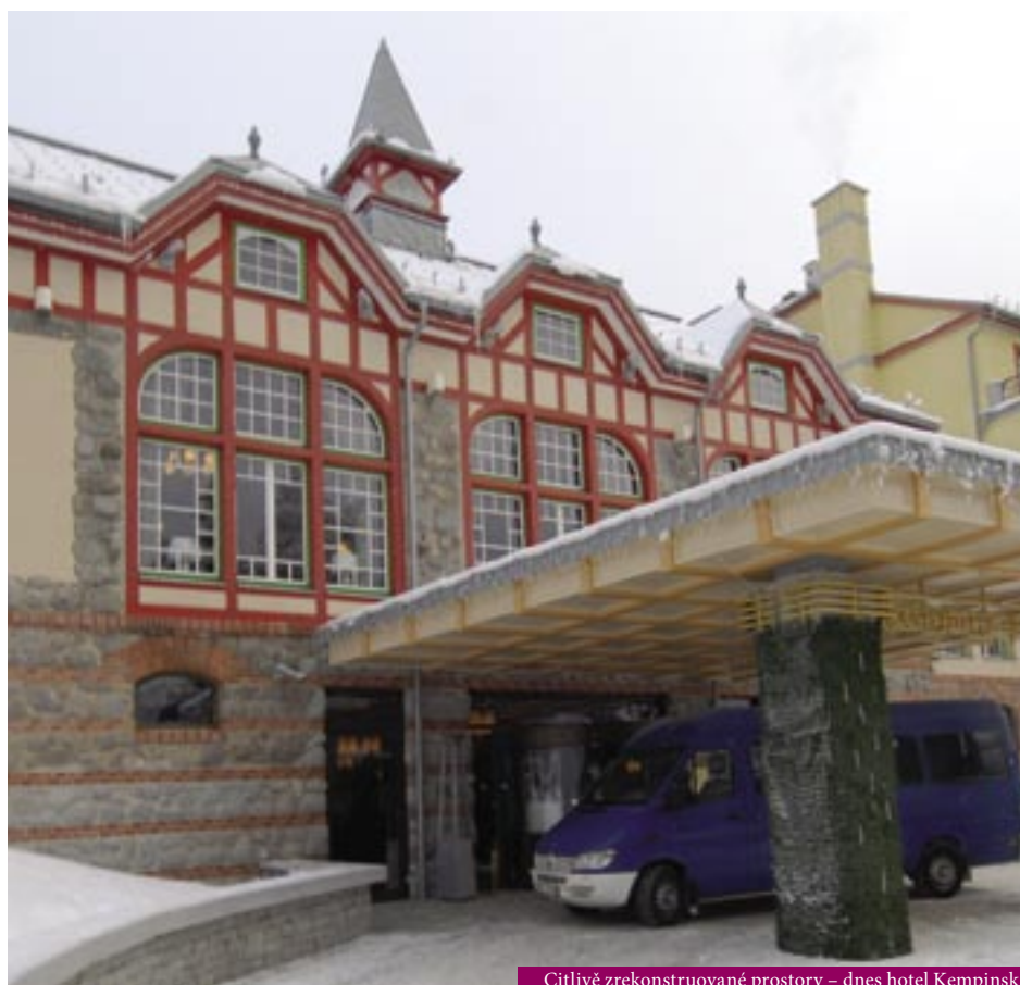
Citlivě zrekonstruované prostory – dnes hotel Kempinski
