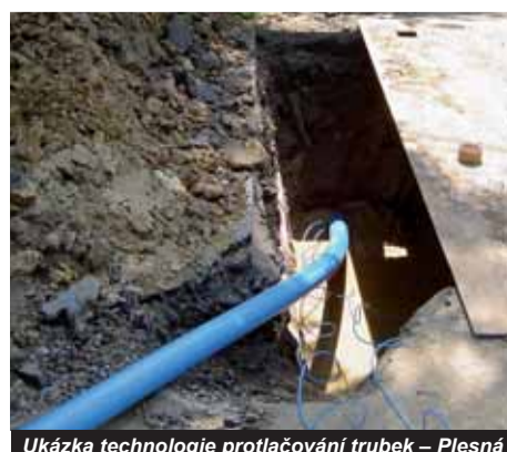
Ukázka technologie protlačování trubek – Plesná
