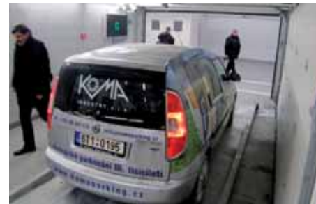
Od této chvíle je vozidlo svěřeno automatickému systému uložení vozidla řízeného počítačem
