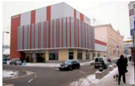
Nový, plně automatizovaný KOMA Parking vznikl v centru Slaného
