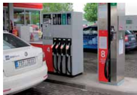
Tady poprvé lze naplnit tlakové nádrže vozidla se CNG pohonem a současně doplnit dojezdovou nádrž benzinem nebo naftou bez přejíždění na jiné místo
