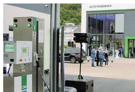
Nová plnicí stanice CNG u Auto Podbabská
