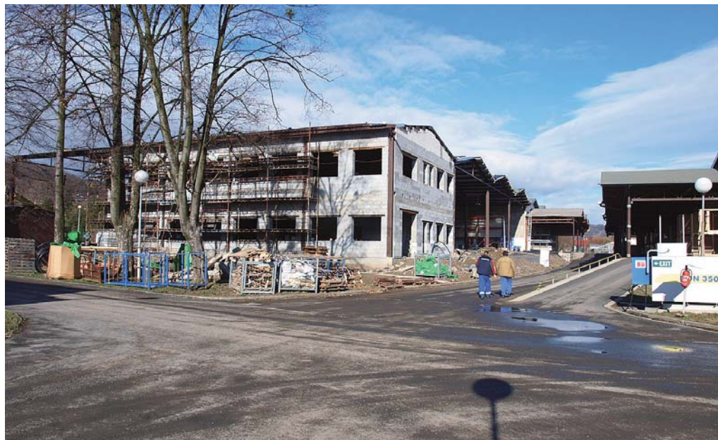
Nové technologické centrum pro vývoj nástrojů a jednoúčelových zařízení v areálu firmy MATEICIUC a. s. v Odrách bude dokončeno ještě letos. V objektu bude mimo jiné nástrojárna včetně jeřábové dráhy a moderního strojového vybavení
