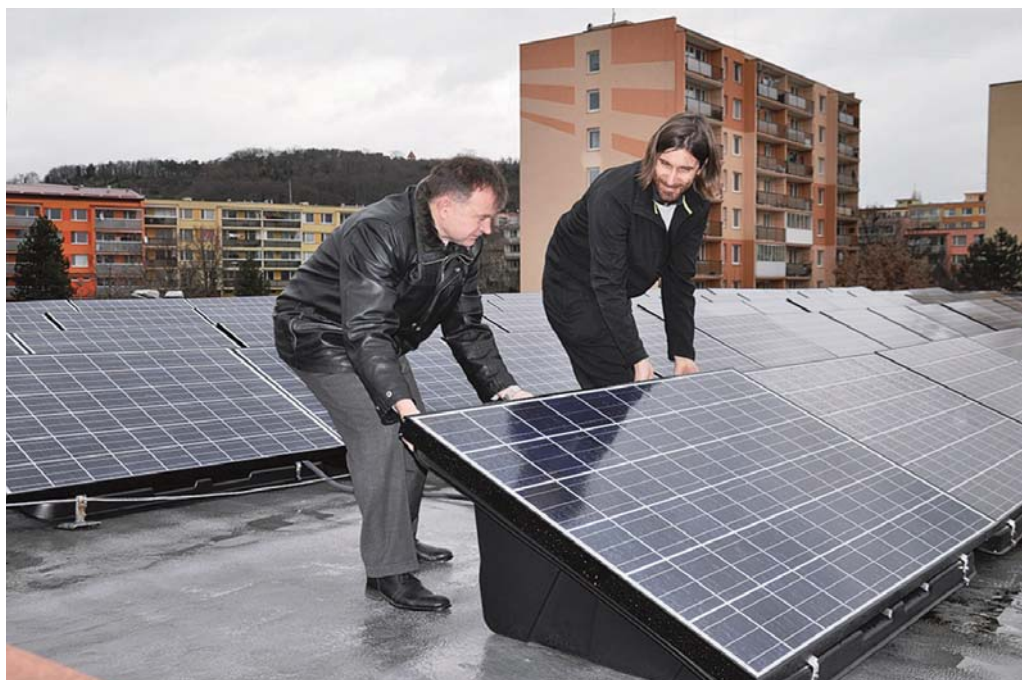
Litoměřice: fotovoltaická elektrárna
