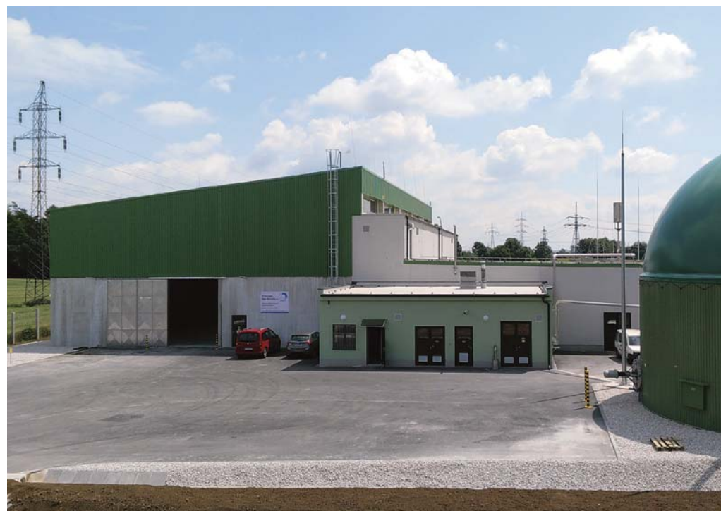
Celkový pohled na bioplynovou stanici
