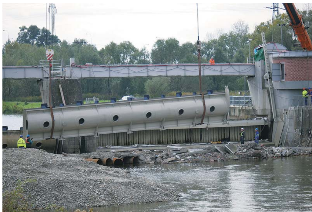
GASCONTROL úspěšně provedl pro Povodí Odry velkou opravu jezu Lhotka na řece Odře, který chrání Ostravu před povodněmi
