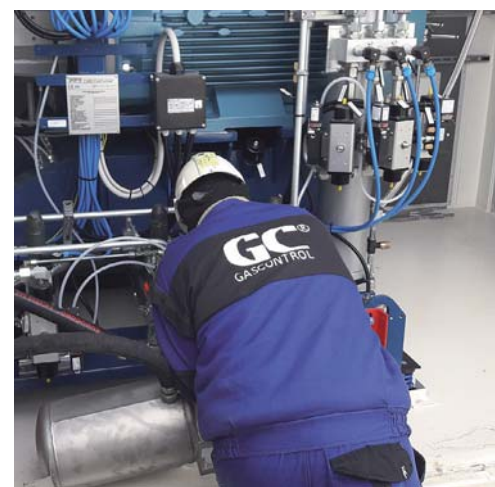
GASCONTROL staví v Orlové plnicí stanici CNG pro autobusy
