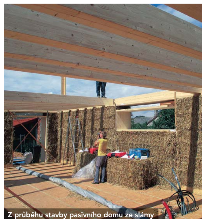
Z průběhu stavby pasivního domu ze slámy
