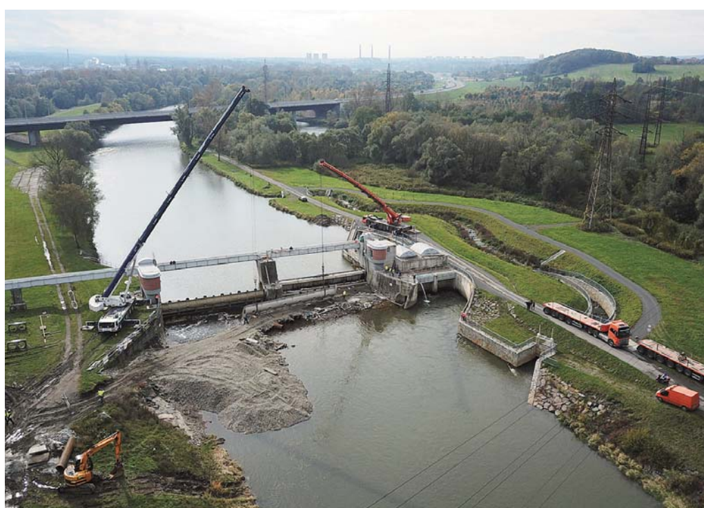
Výměna dvou mohutných ocelových klapek na jezu Lhotka na řece Odře, který chrání Ostravu před povodněmi, byla pro GASCONTROL jedním z technicky nejnáročnějších projektů za poslední dva roky
