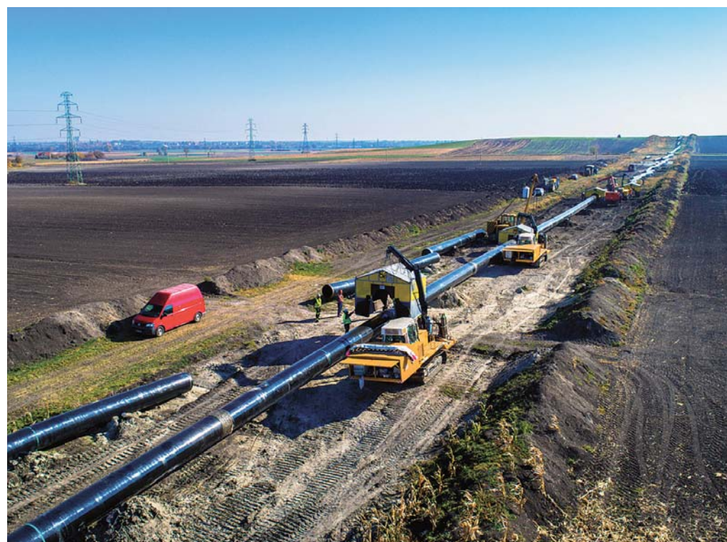
Nasazení svařovacích automatů nové generace
