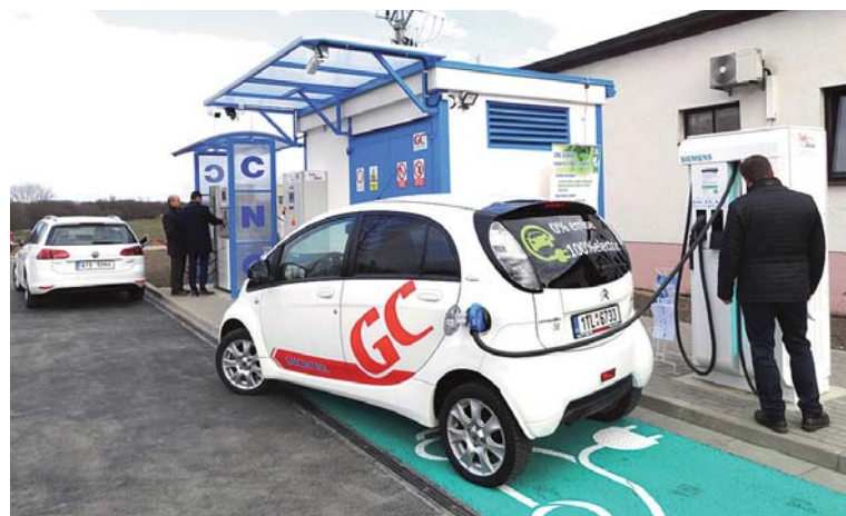
Celkový pohled na CNG plnicí stanici v kombinaci s rychlonabíjecím zařízením pro elektromobily
