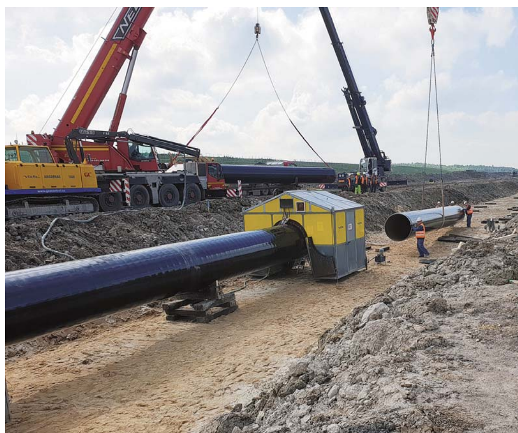
Svařovací automaty firmy GASCONTROL na stavbě Hořanského koridoru
