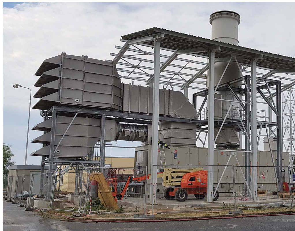
Instalace turbosoustrojí v kompresorové stanici Kouřim
