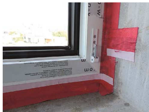
Správné zalepení rohu okna ochrannými fóliemi
