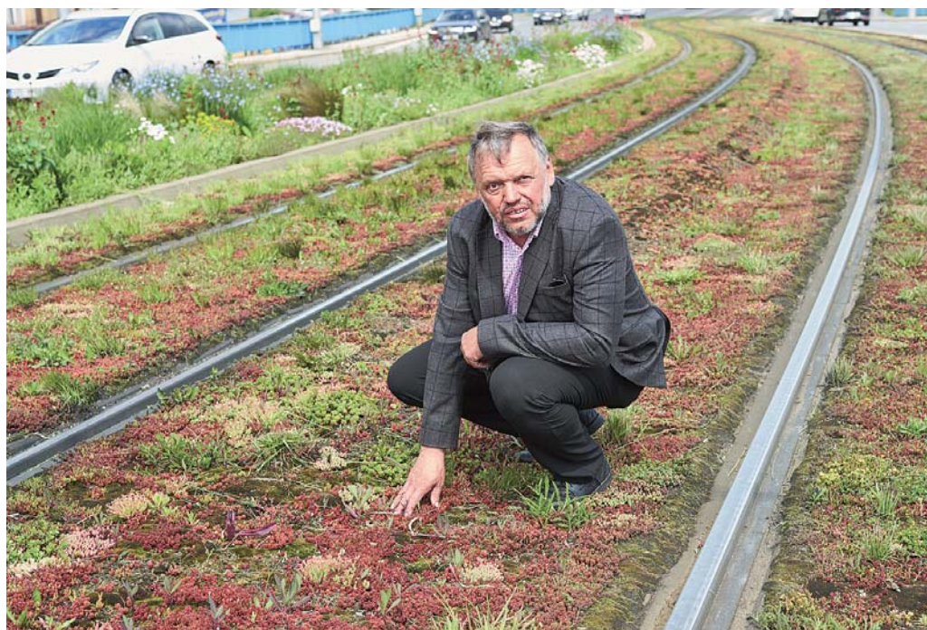
Jan Eisenreich, ředitel, BRENS Europe a.s., patentovaná technologie osazení tramvajových pásů ve městech vegetací snižuje hluk i vibrace a zachycuje prach i vodu
