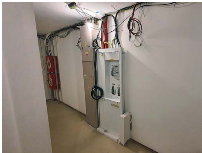
Interiér bytového domu před rekonstrukcí a po ní
